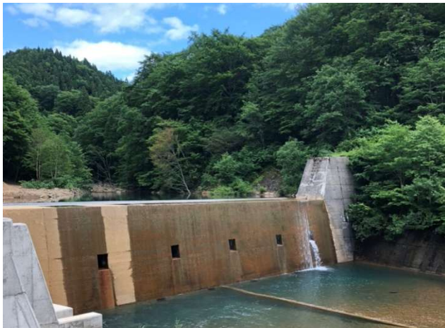
鶴の湯水力発電所 取水堰堤
